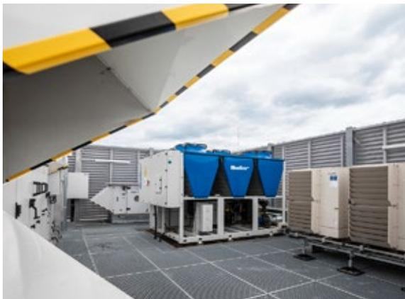
↑ O edifício é aquecido e arrefecido através de uma bomba de calor e sistema de refrigeração.
