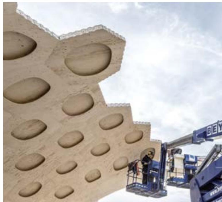
→ As caixas em madeira reduzem significativamente o peso e o material, mas, ainda assim formam uma estrutura de suporte extremamente eficiente.
